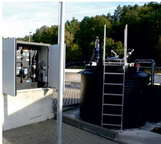
Fördermenge wird über eine Messeinrichtung im Becken angesteuert und sichert, entsprechend des Abwasserzustandes, eine optimale Zuführung des Dosiermediums. Die Voraussetzungen für die Einbindung in ein Prozessleitsystem sind gegeben.
