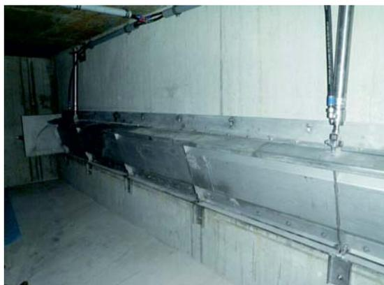
folge eines sich aufbauenden Wasserdruckes. Die Systeme des RW-W-ELT und des RW-W-HYD wirken gemäß Messungen und Einleitung von Regelungsenergie. Mit deren Hilfe können einstellbare Oberwasserpegel konstant gehalten werden. Nach dem Rückgang der Ereignisse nehmen die Wehrklappen ihre ursprünglich geplante Position wieder ein.
